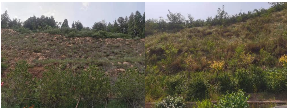
图 4 边坡恢复现状
