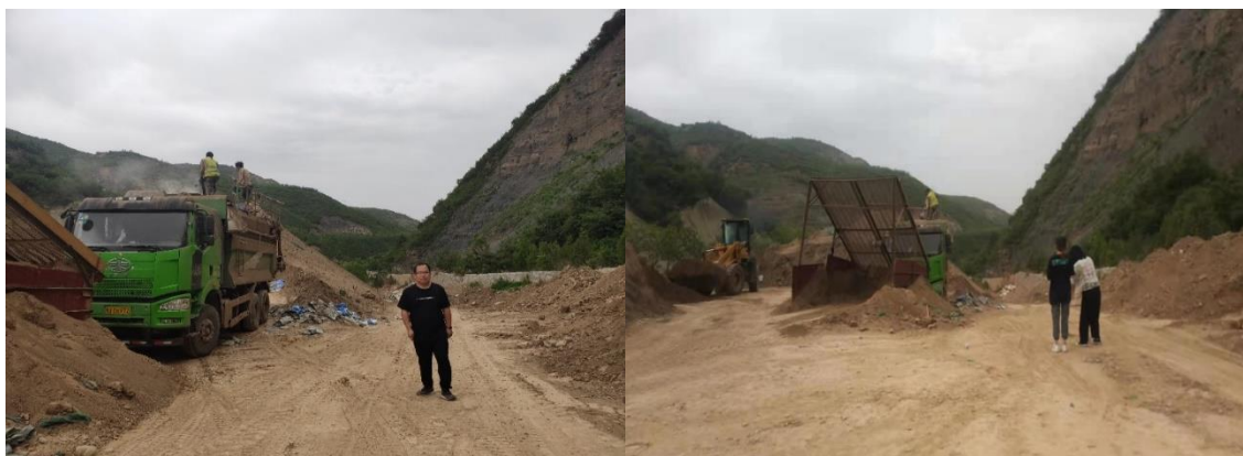
图 1 客土喷播技术施工现场
